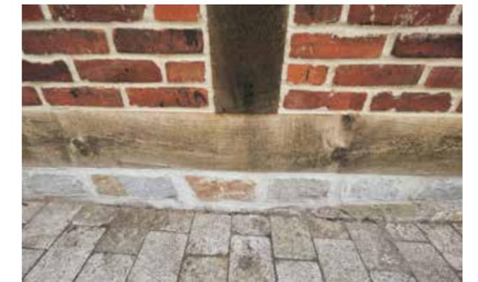
**Schwellentausch** Über die Jahre hatte die Schwelle der Scheune gelitten, ein Austausch war unumgänglich. Ein schwieriges Unterfangen, für das das gesamte Gebäude abgestützt werden musste.
