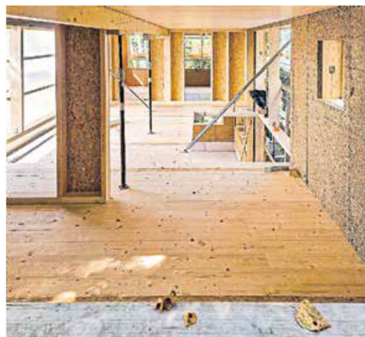
Ein Blick durch das Obergeschoss: In der Mitte ist die Galerie zu erkennen, links das künftige Elternschlafzimmer, hinten die beiden Kinderzimmer. Über dem Luftraum rechts soll ein Netz gespannt werden. Die Wand rechts ist bereits mit Strohplatten verkleidet.
