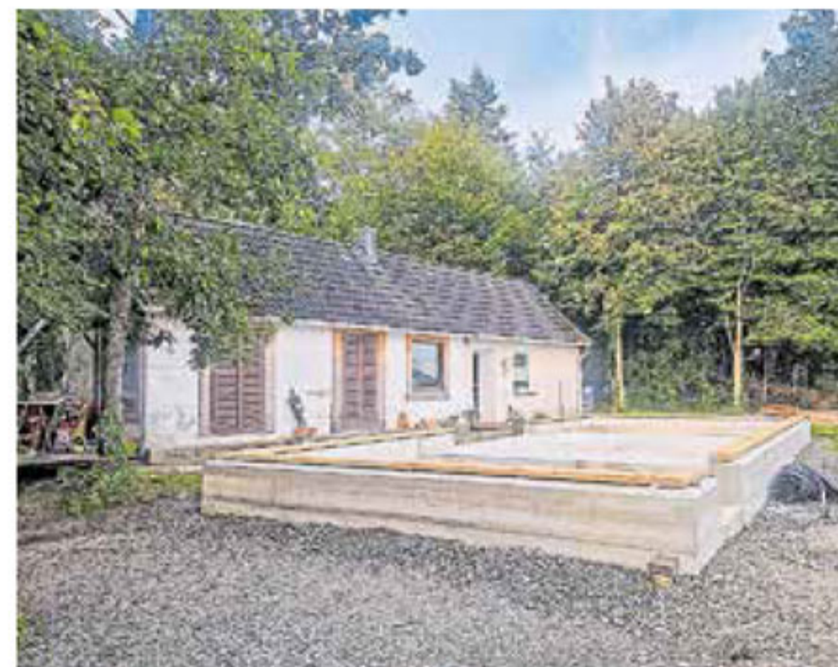
Auf diesem Fundament ruht inzwischen der Neubau. Das alte Haus im Hintergrund weicht nach dem Umzug.
