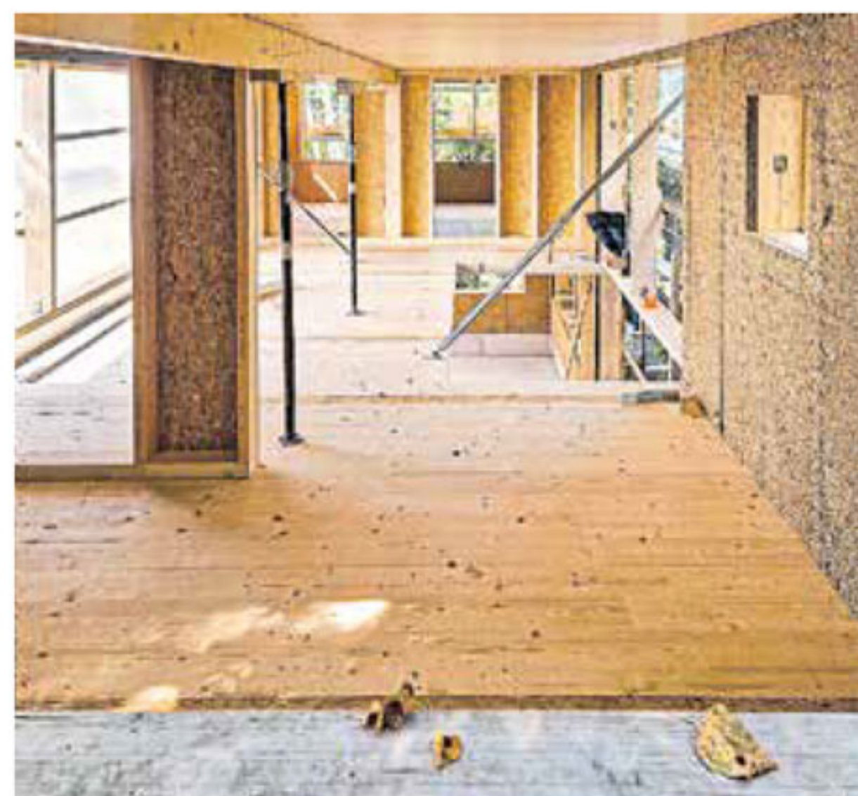
Ein Blick durch das Obergeschoss: In der Mitte ist die Galerie zu erkennen, links das künftige Elternschlafzimmer, hinten die beiden Kinderzimmer. Über dem Luftraum rechts soll ein Netz gespannt werden. Die Wand rechts ist bereits mit Strohplatten verkleidet.
