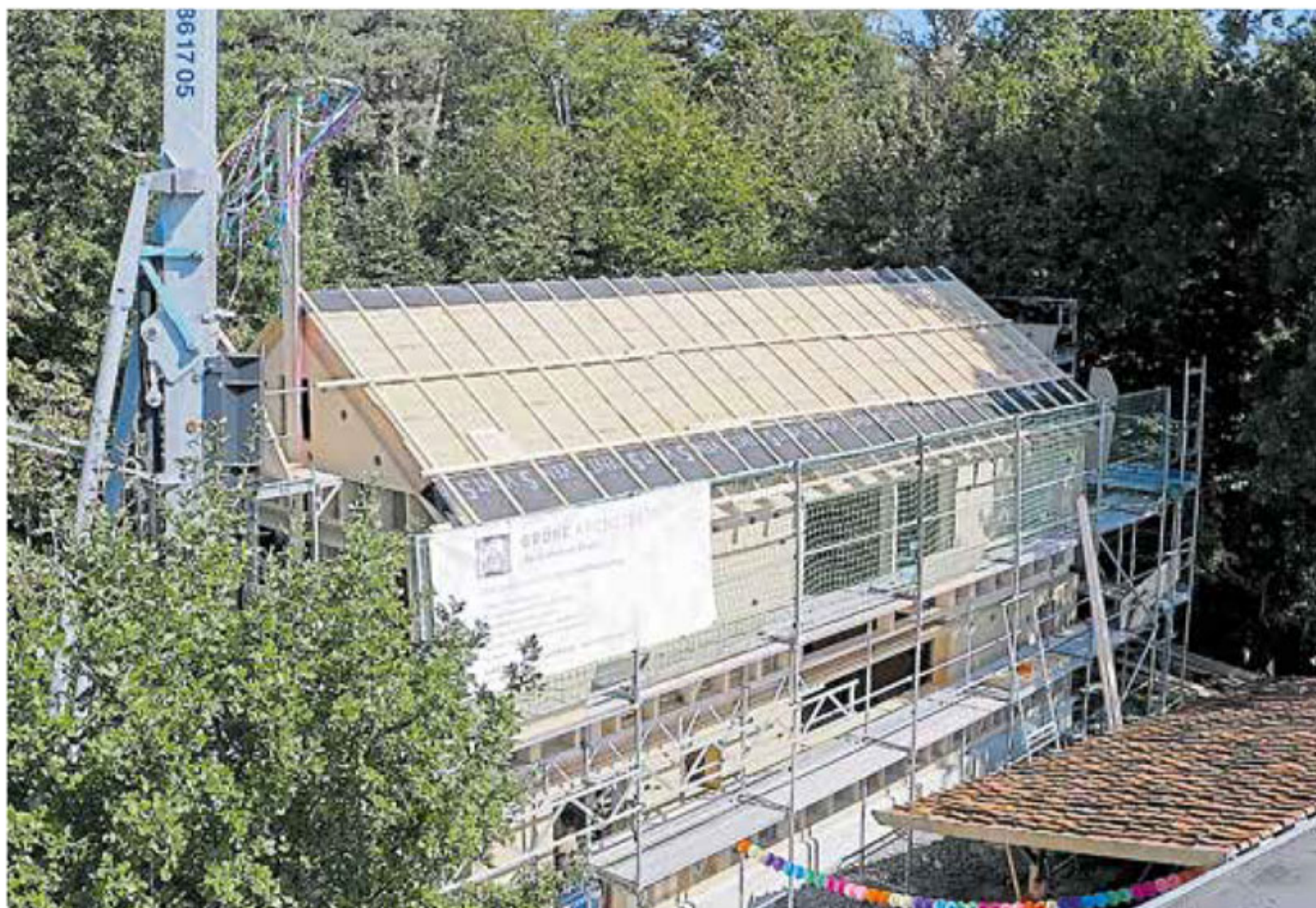
Innerhalb einer Woche stand der Rohbau inklusive Dachstuhl. Der Baukörper umfasst zwei Vollgeschosse und fügt sich zwischen den vorhandenen Bäumen ein.
