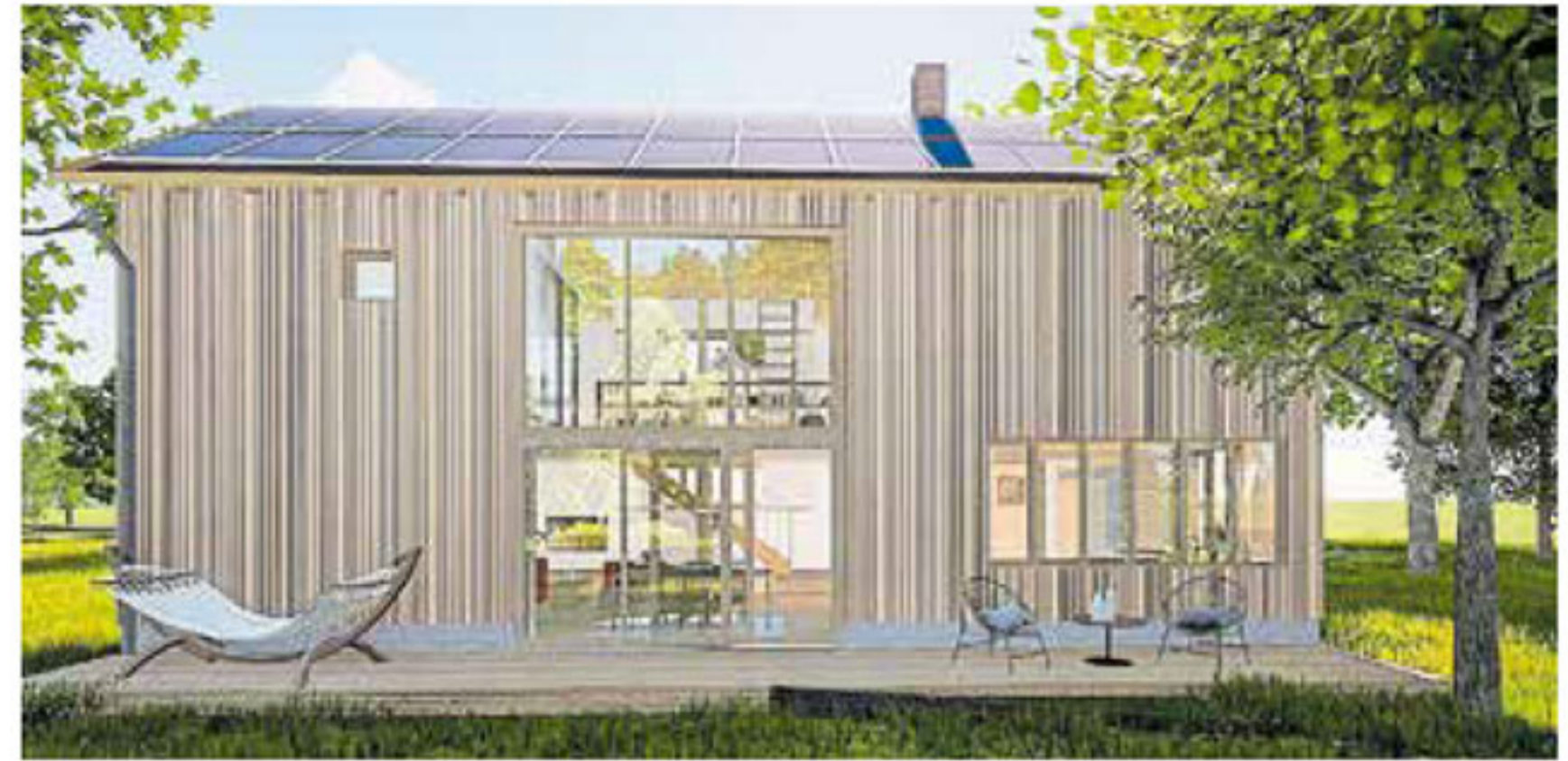
Die große Fensteröffnung auf der Gartenseite nimmt die Form eines Deelentores auf. Das Dach soll künftig Photovoltaik-Module tragen.
